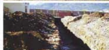
Scavi fondamenta warehouse
