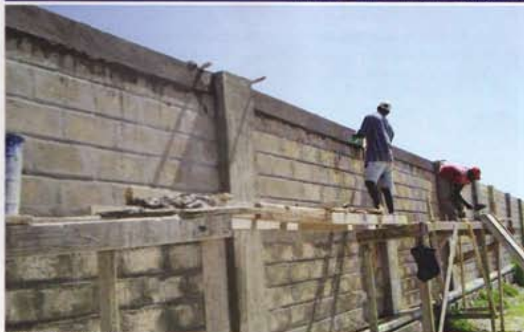
Muri di cinta riparati!
